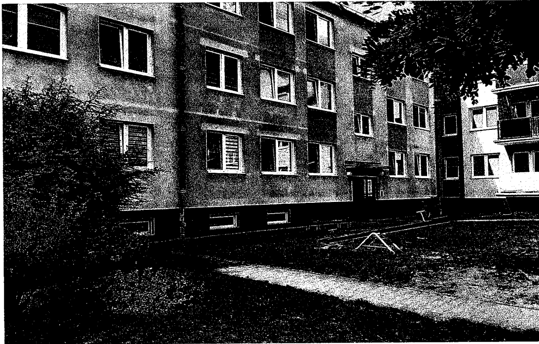
Fot. Budynek wielolokalowy ul. Rzeźnicza 2, 4 i ul. Rybacka 6A, B w Żmigrodzie.
