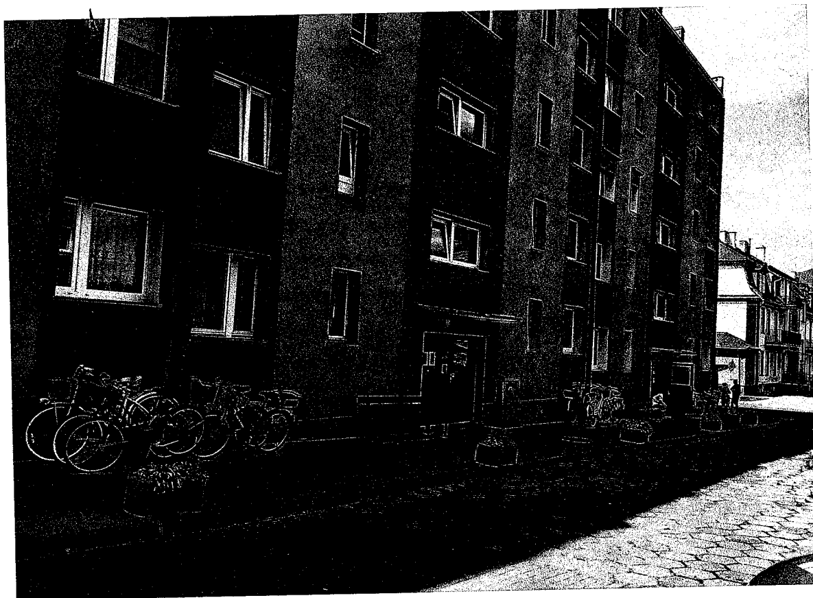
Fot. budynek wielolokalowy ul. Lipowa 2 ABCD w Żmigrodzie.
